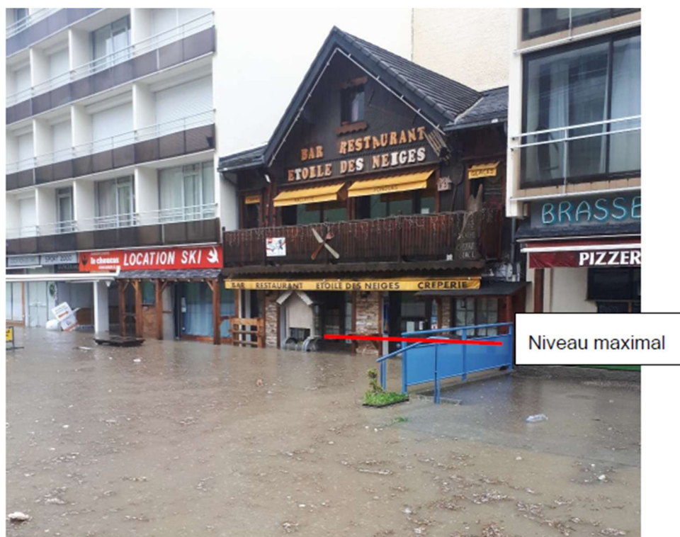
Figure 17 : Niveau d'eau atteint sur les commerces de la place Sarrière le 18/06/2018
