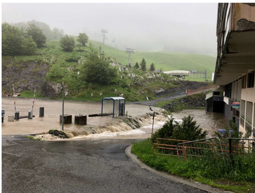
Figure 11 : Débordement du Valentin sur la partie amont de la station (parking d'Anglas) le 18/06/2018
