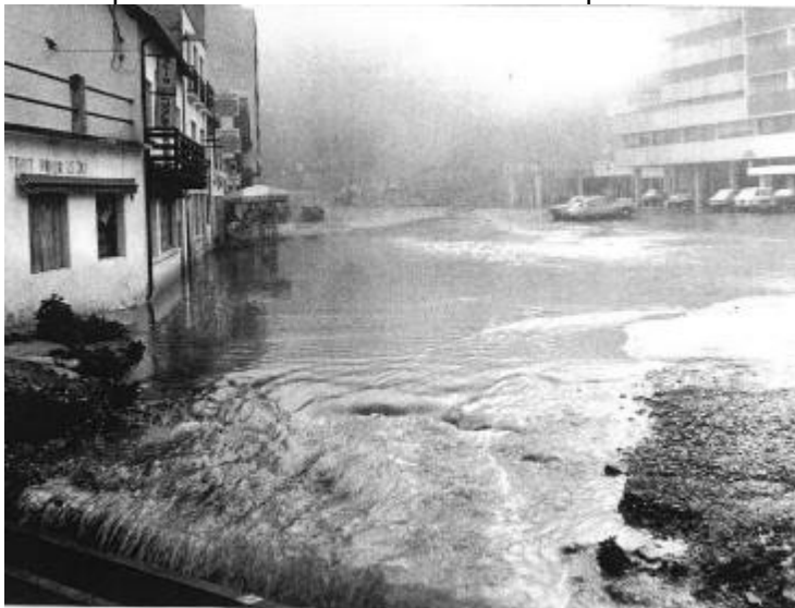
Figure 18 : Photo de l'avaloir de la place Sarrière dans les années 70
